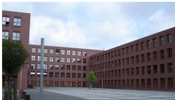
Schulgebäude der Wilhelm – Ostwald – Schule
